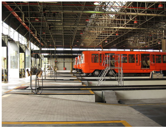
FIGURE 2.7. – Zone de maintenance (Domaine Public Romainbehar)
