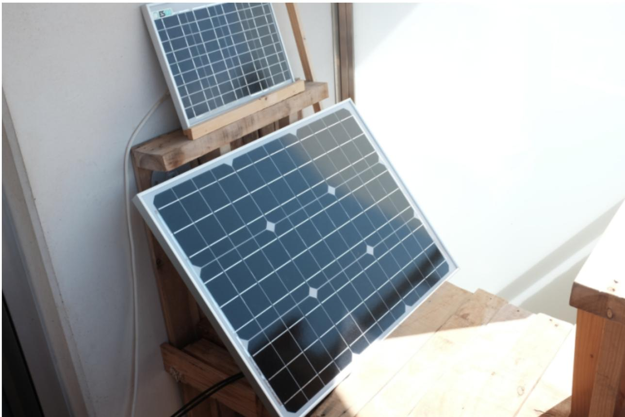
FIGURE 4. – Panneau solaire de 50. En haut, c'est un panneau solaire de 10W alimentant le système d'éclairage.
